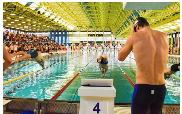
Schwimmhalle der Sportfördergruppe der Bundeswehr in Warendorf
