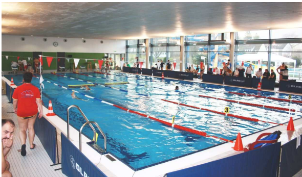
Die Schwimmhalle in frisch sanierten 5-Täler Bad in Geislingen
